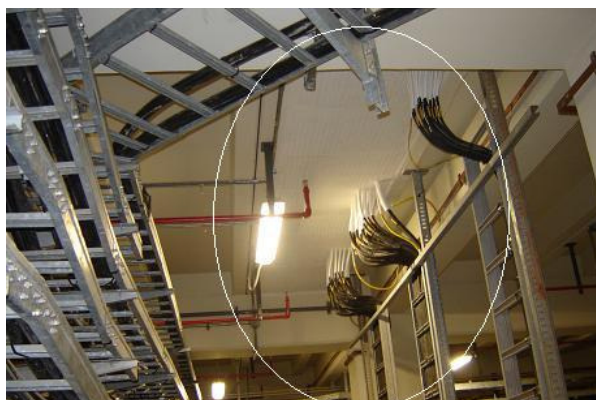
ПИРО-СЕЙФ ФЛАММОТЕКТШОТТ КОМБИ S90, исполнение в перекрытии
