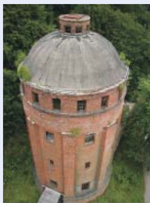
Рис.3. Усиление купола исторического здания в Дрездене полимерными сетками и полимерцементными смесями
