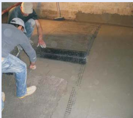
Рис.2. Усиление кирпичного свода сетками из углеродных волокон
