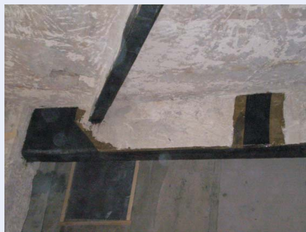
Рис.4. Усиление железобетонных плит возведения 1898г. в здании-памятнике архитектуры по адресу: г.Москва. Чистопрудный бульвар д.6/19
