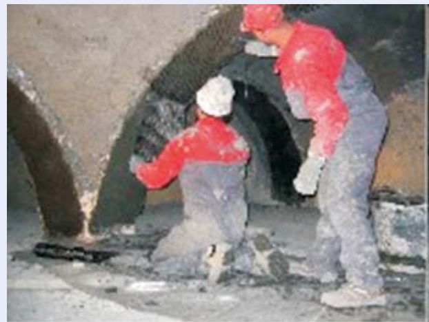
Рис.1. Усиление арочных конструкций композитными материалами
