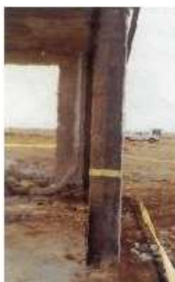
б) колонна усиленная углепластиком
