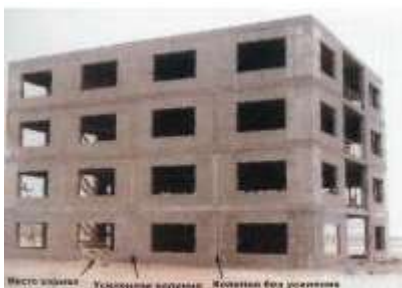
Рис. 1. Экспериментальное здание для испытания колонн на взрывную нагрузку
