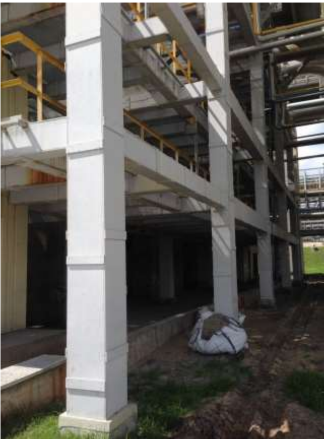
Повышение огнестойкости металлоконструкций ТАТНЕФТЬ, до R90- R120 , Россия, 2013-2017
