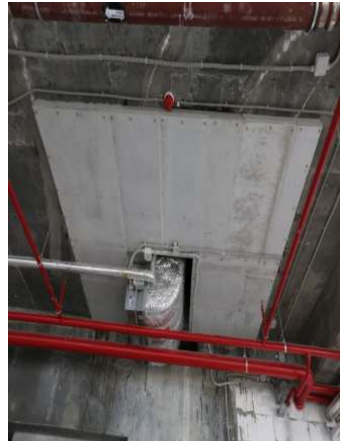
Повышение огнестойкости железобетонных перекрытий в районе проемов (усиленных углекомпозитными матрицами), до REI 240 , Москва-СИТИ, 2013-2017 гг
