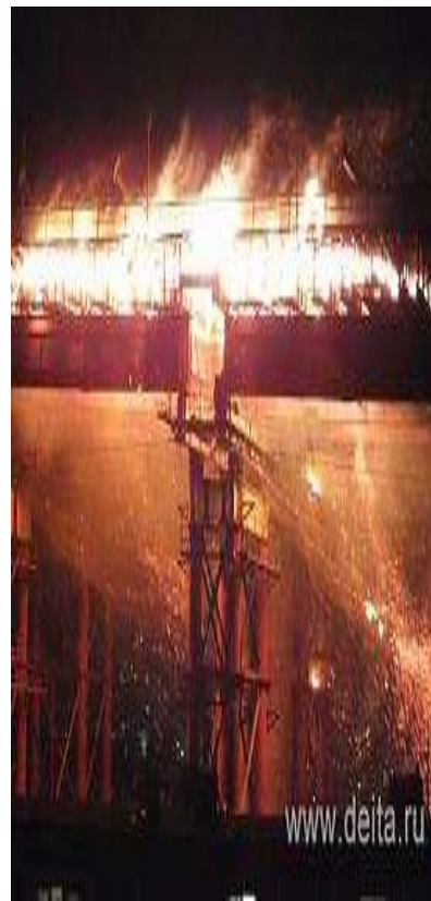
Около 1200 кв. м бетона было повреждено во время пожара при строительстве моста ч/з бухту Золотой Рог . Был осуществлен гидродемонтаж бетона
