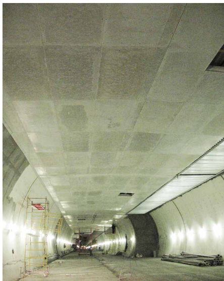
Рокский тоннель. Северная Осетия
