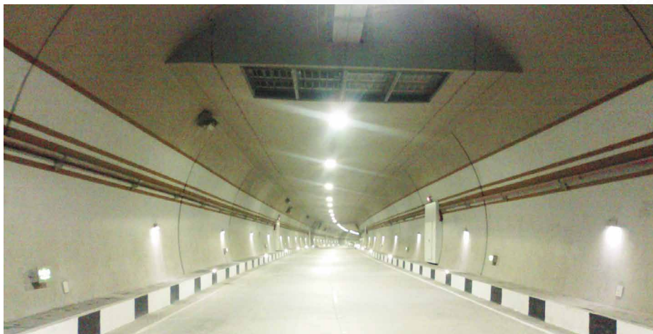
Тоннель №1, дублер Курортного проспекта, г. Сочи
