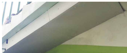
ПАО «Казаньоргсинтез». Огнезащита лестничного стального каркаса
