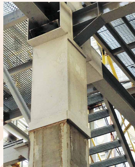
ОАО «ТАНЕКО». Огнезащита стальных конструкций эстакад
