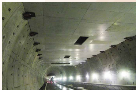
Автодорожный тоннель №2 комплекса тоннелей №3 Адлер — Альпика-Сервис
