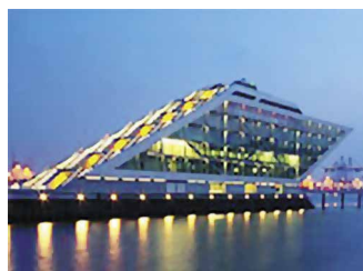
Комплексные работы по огнезащите конструкций и коммуникаций в здании, Германия
