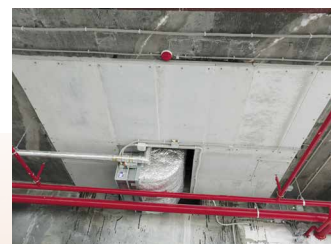
Огнезащита системы усиления железобетонных конструкций, Россия, ММДЦ «Москва-Сити»
