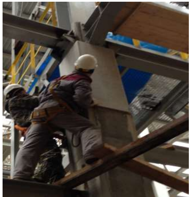
Выполнение огнезащиты металлоконструкций на НПЗ ТАНЕКО, г. Нижнекамск, 2013-2017 г.
