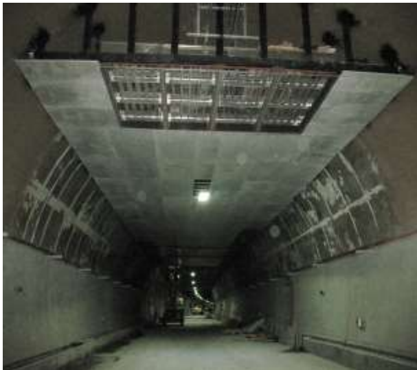
Огнезащита тоннеля №1 Дублера Курортного проспекта, г.Сочи, 2011-2012 г.
