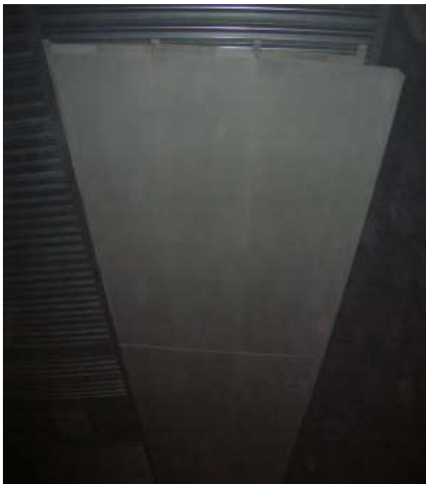
Огнезащита Рокского тоннеля, Северная Осетия, 2013-2014 г
