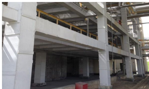
ОАО «ТАНЕКО». Огнезащита стальных конструкций эстакад, г. Нижнекамск
