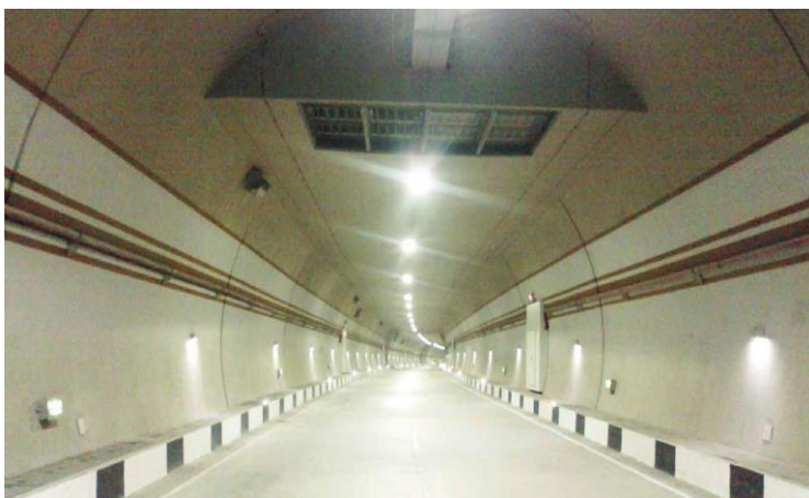
Тоннель №1, дублер Курортного проспекта. Огнезащита канала дымоудаления, г. Сочи
