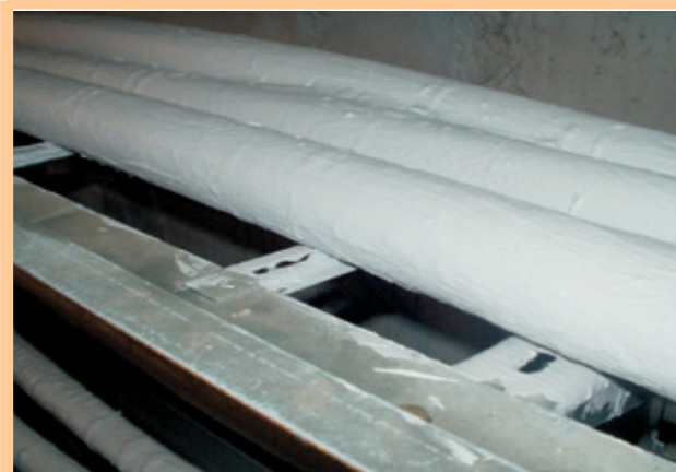
Покрытый противопожарным покрытием кабель на кабельной трассе
