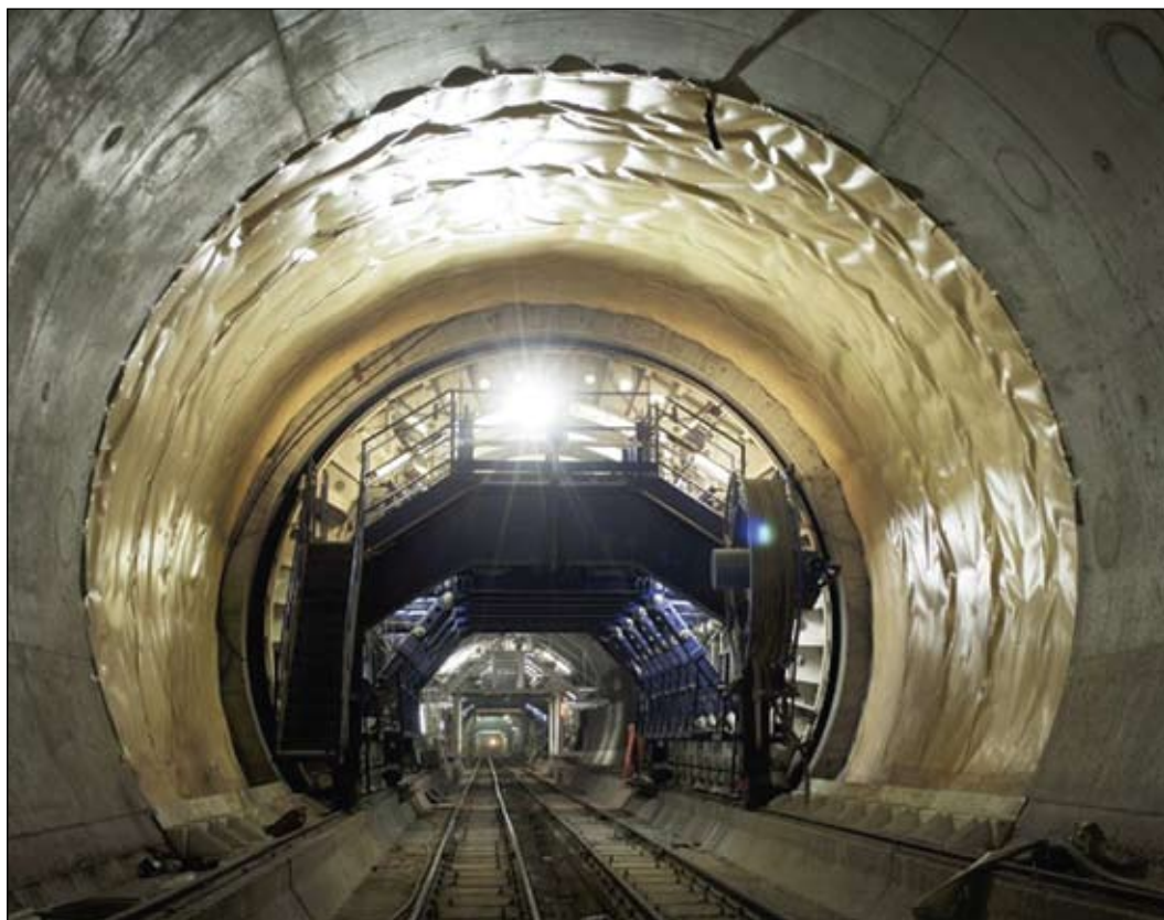
Устройство гидроизоляции тоннеля
