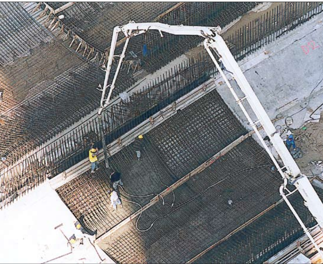
Сооружение конструкций тоннеля
