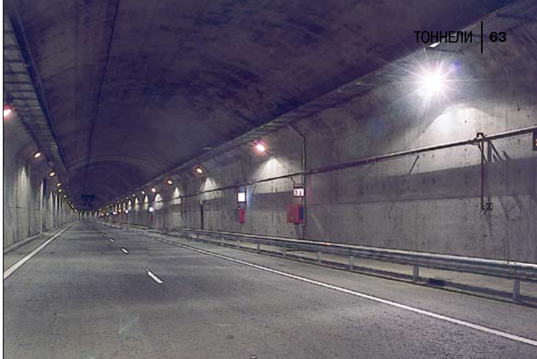
Внутренний вид автодорожного тоннеля
