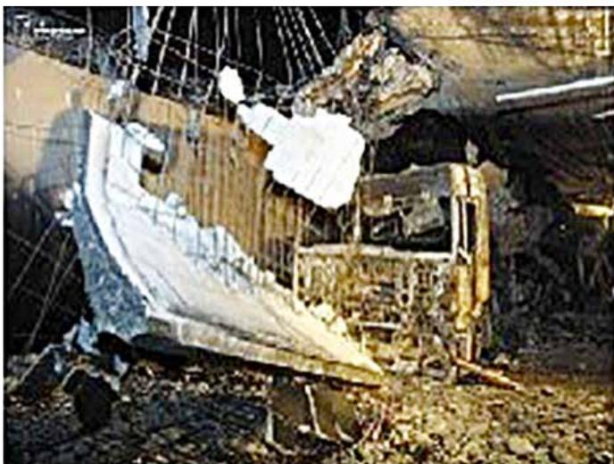
Результаты пожара в тоннеле St Gotthard Tunnel, 2001
