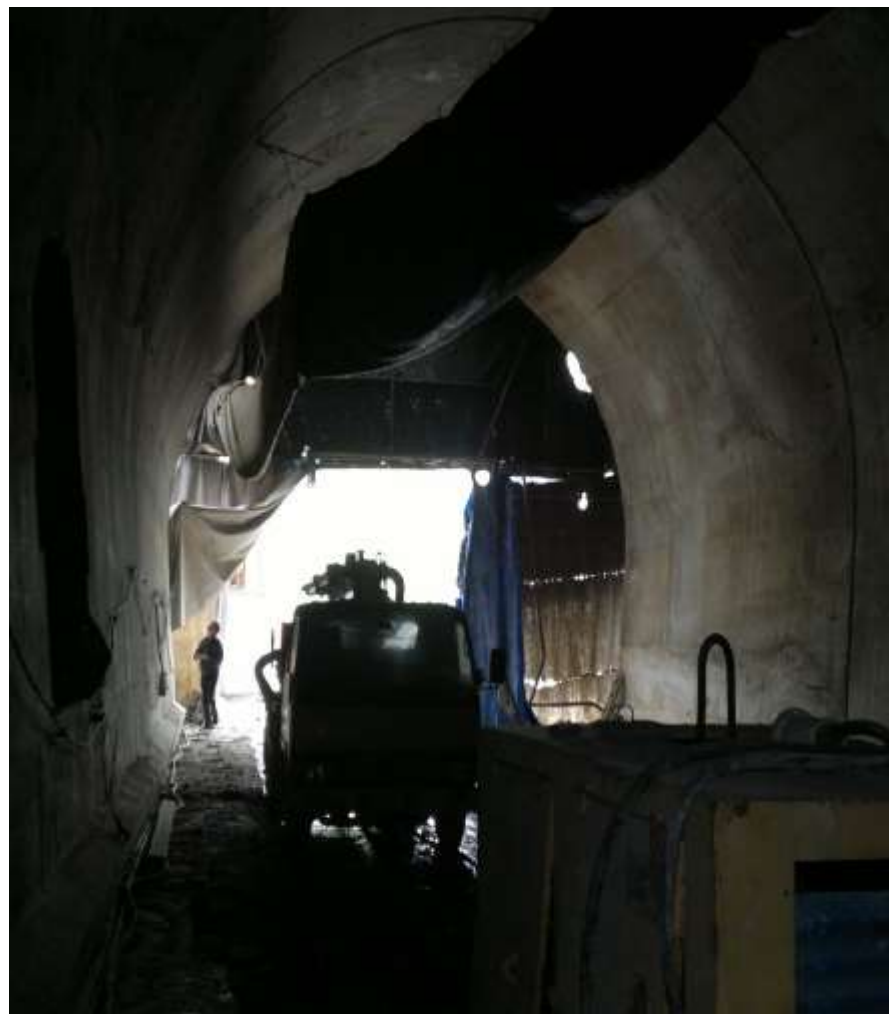
Огнезащитная облицовка свода тоннеля
