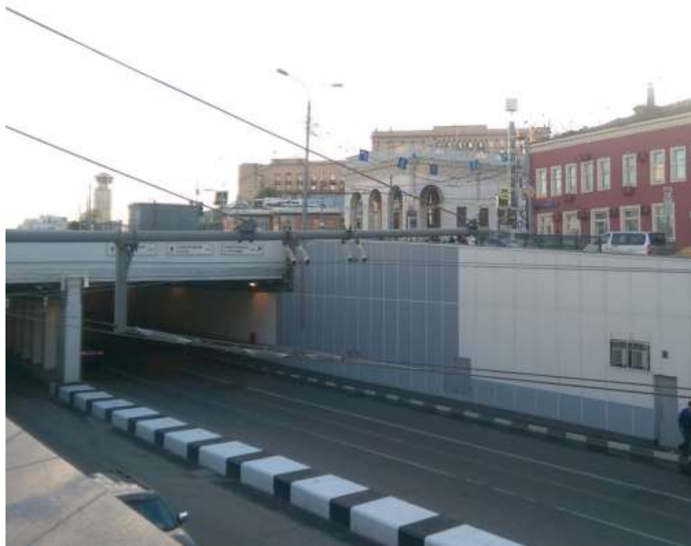
Таганский тоннель , Москва, 2015 г
