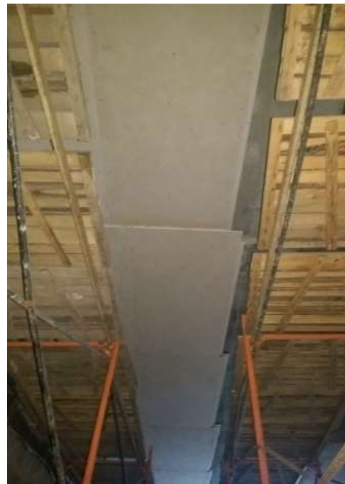
Огнезащитная облицовка свода тоннеля
