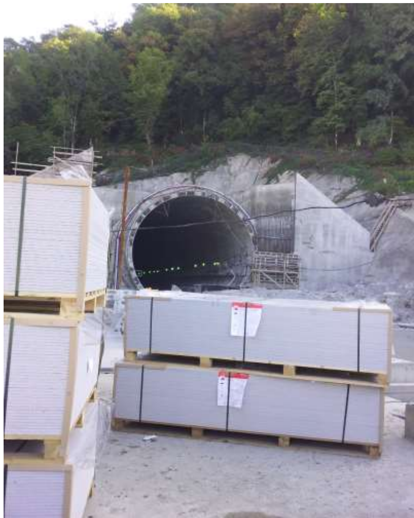
Тоннель №2 автодорожный на Альпику-Сервис, г. Сочи, 2012-2013 г
