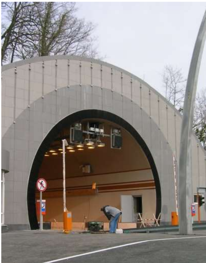
Тоннель №1 Дублера Курортного проспекта г. Сочи, 2011 г
