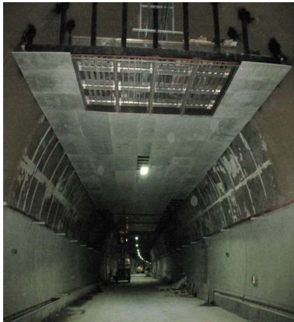
Вид на канал дымоудаления
