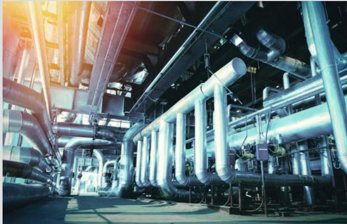
Вспомогательные сварные металлоконструкции устанавливаются в процессе монтажа тяжелых трубопроводов или кабель-каналов и часто включают в себя площадки или мости, которые используются для обслуживания коммуникаций.
