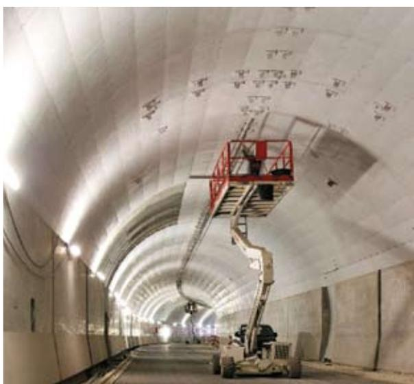
Плиты огнезащитные на цементном связующем с легким минеральным наполнителем, армированные с двух сторон стеклосеткой, с односторонним защитным покрытием «ПРОЗАСК Файерпанель» (Россия) и огнезащитные плиты «PSAESTUVERT» (Германия).
