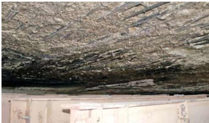
Около 1200 кв. м бетона было повреждено во время пожара при строительстве моста через бухту Золотой Рог. Был осуществлен гидродемонтаж бетона
